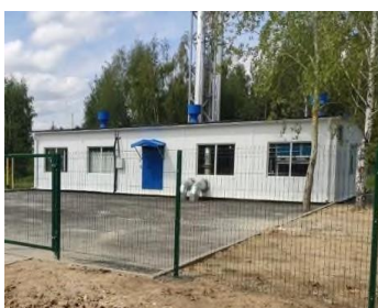
БМК п. Авсюнино (12,6 МВт)
