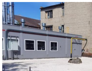
БМК д. Новое (9,0 МВт)
