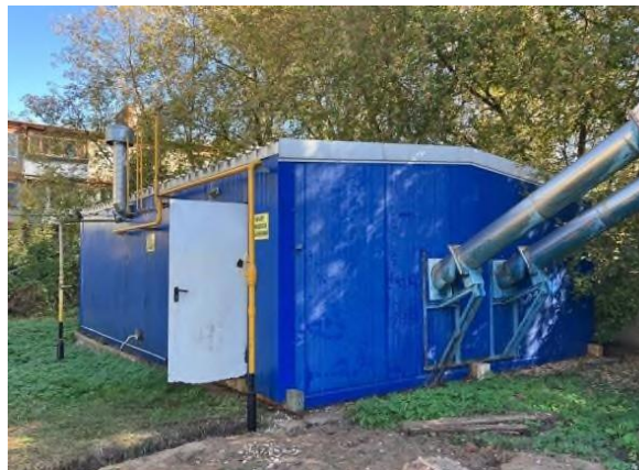
Перевод на природный газ котельной Торфобрикетная
