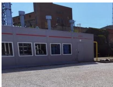
БМК № 8, г. Ликино-Дулево (6,9 МВт)
