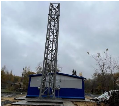
БМК с. Хотейчи (0,4 МВт)
