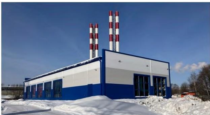
БМК ЛИАЗ г. Ликино-Дулево (40 МВт)
