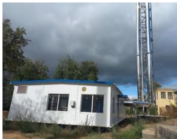
БМК № 1, г. Ликино-Дулево (12,6 МВт)
