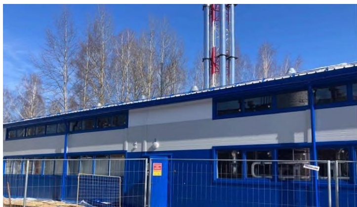
БМК п. Верея (11,9 МВт)
