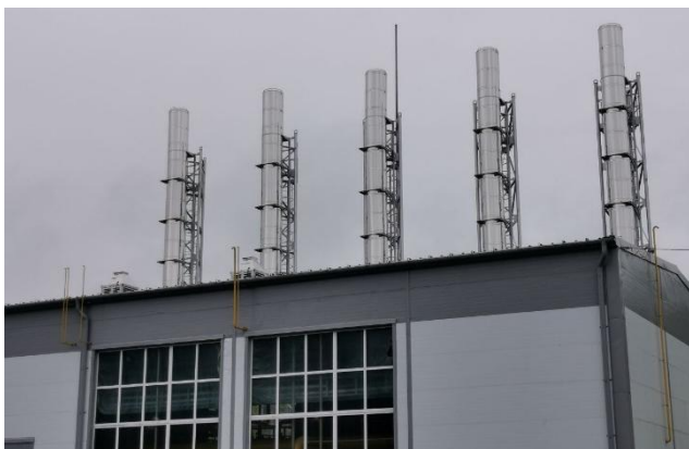
Центральная районная котельная г. Корсаков
