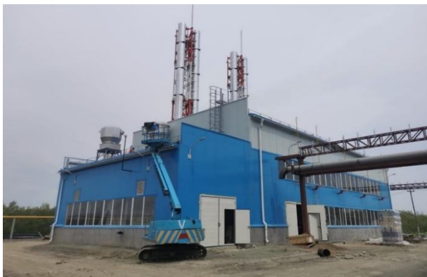
Центральная котельная г. Долинск
